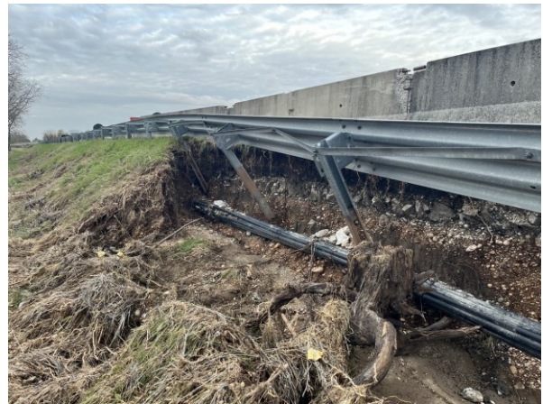
Foto 4 - S.R. 305var dettaglio fibra ottica
